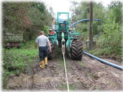
Beim Einpflügen von Rohrleitungen wird der Verlegepflug vom Zugfahrzeug (die beiden Arbeitsmaschinen sind über ein Stahlseil miteinander verbunden) mit der enormen Kraft von 50 bis 100 Tonnen durch das Erdreich gezogen. Die Zugkraft ist abhängig von den Bodenverhältnissen.
